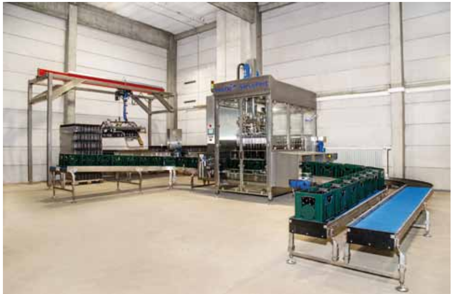
Neue Verpackungsanlage zum Ein- und Umpacken von Leer- und Vollflaschen in Kästen und Kartons
